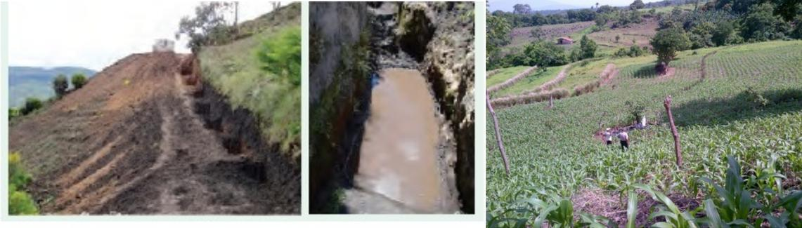
Zanjas de infiltración
