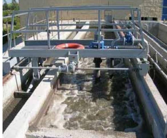
Figura 4.7. a) Desengrasador estático; b) Desarenador-desengrasador aireado
