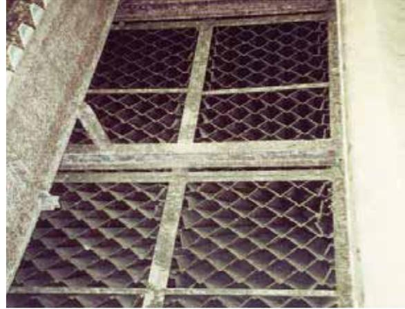
Figura 4.12. a) Sedimentador primario estático (San Luis Talpa, El Salvador), b) Detalle de un decantador lamelar
