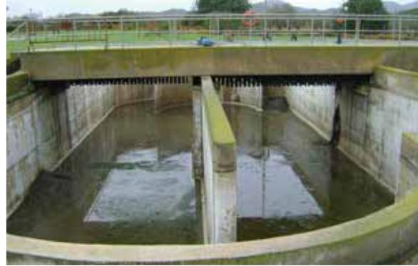
Figura 5.5.9. Canal de oxidación
