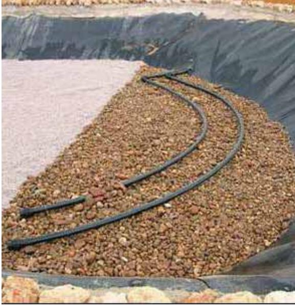
Figura 5.4.5. Tuberías de alimentación apoyadas en la zona de cabecera
