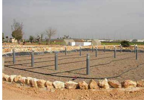
Figura 5.4.9. Tuberías de alimentación apoyadas sobre el lecho
