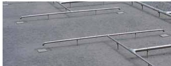
Figura 5.4.10. Tuberías de alimentación apoyadas en pivotes (Fuente: Epur Nature)
