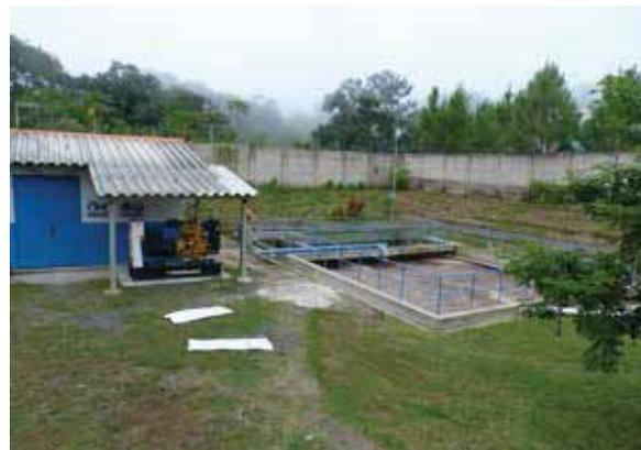
Figura 2.5. Tratamiento de aireación extendida. PTAR Quintas Doradas
