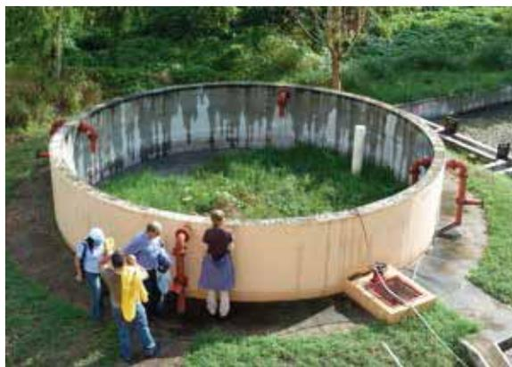
Figura 3.5. Digestor anaerobio abierto a temperatura ambiente
