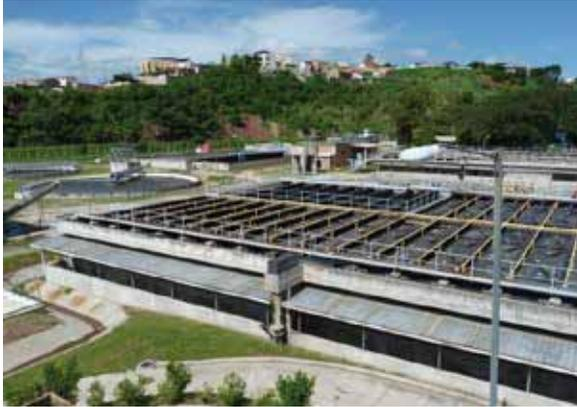
Figura 5.2.2. Reactores anaerobios de flujo ascendente
