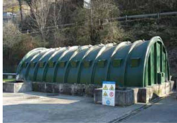
Figura 3.4. Filtros Percoladores y Contactor Biológico Rotativo
