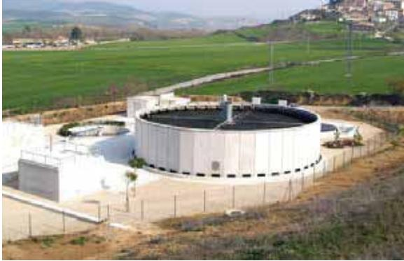
Figura 5.1.3. Filtro percolador circular con distribución móvil
