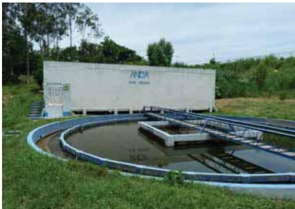
Figura 2.4. Filtro Percolador. PTAR de Apaneca
