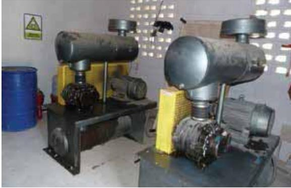
Figura 5.5.5. Sistema de inyección de aire mediante compresores
