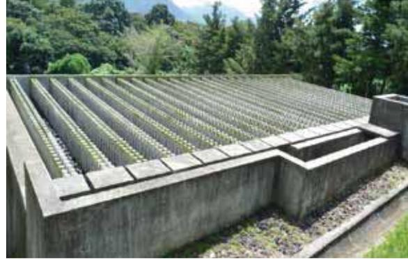
Figura 5.1.4. Filtro percolador rectangular con distribución fija
