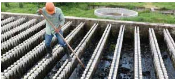
Figura 8.6. Labores de mantenimiento en un filtro percolador
