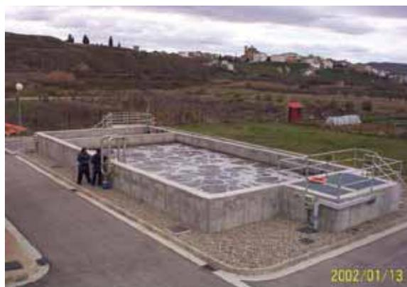
Figura 5.5.2. PTAR de aireación extendida
