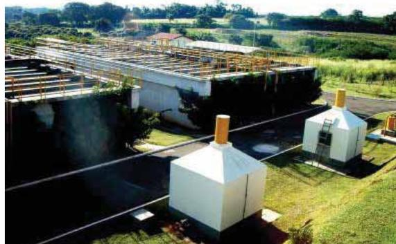
Figura 3.1. Tratamiento anaerobio mediante RAFA
