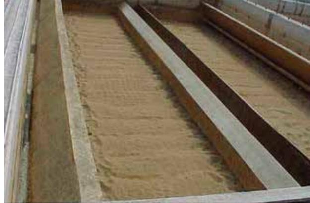
Figura 6.4 Filtros de arena: a) de gravedad y b) de presión
