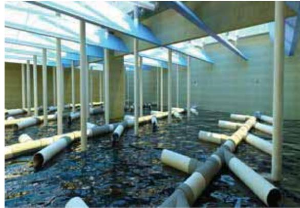
Figura 5.2.3. Sistema de distribución de la alimentación
