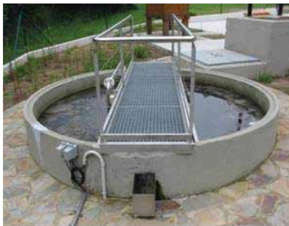
Figura 5.6.3. Sedimentador secundario estático
